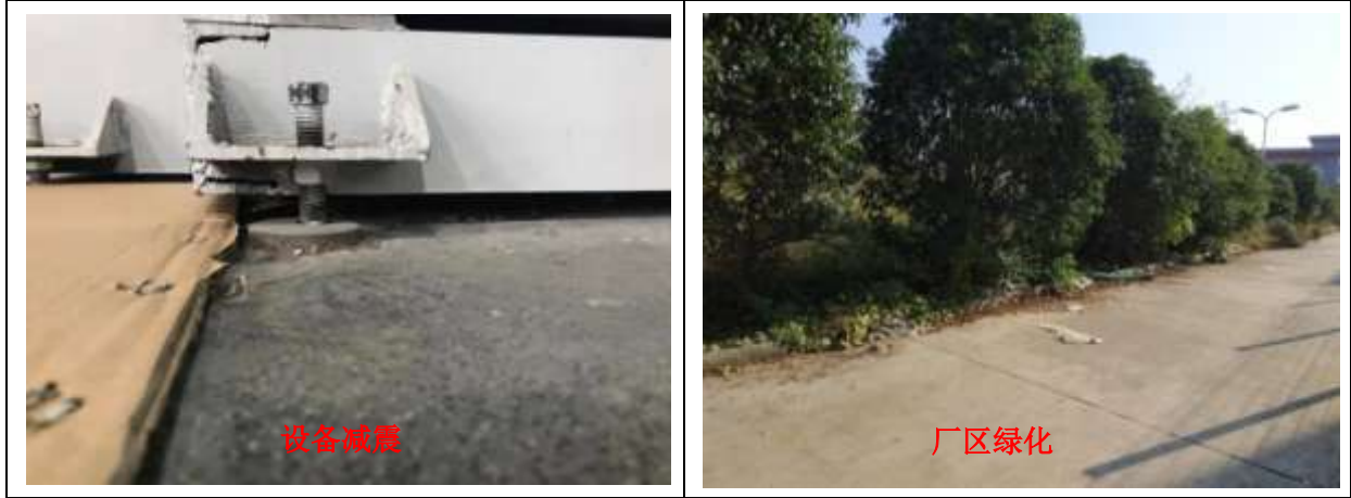
图 4.1.3 防噪措施现场照片
